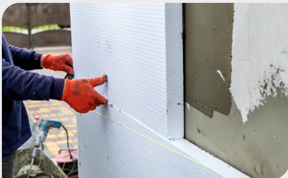
ISOLATION DES MURS EXTÉRIEURS
