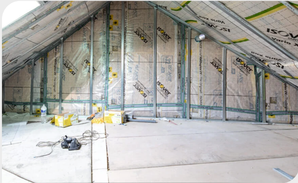
ISOLATION THERMIQUE SOUS RAMPANTS ET MURS INTÉRIEURS
