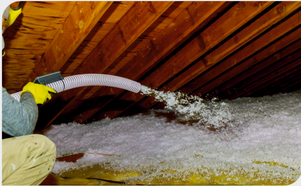
ISOLATION PAR SOUFFLAGE
