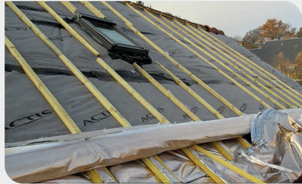
ISOLATION EXTÉRIEURE SOUS COUVERTURE
